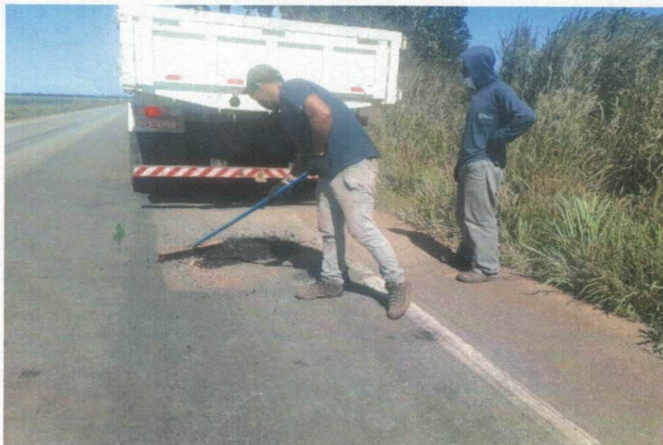
IMAGEM 01 e 02– Recuperação em execução. TO-050
