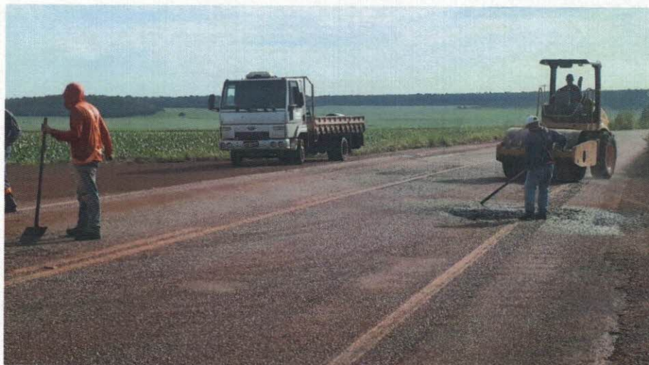
Imagem – Intervenção de tapa buraco TO-020 Palmas / Aparecida do Rio Negro
