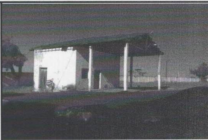
FOTO 28 - Depósito de Ferramentas e Placa de Sinalização da Ageto.
