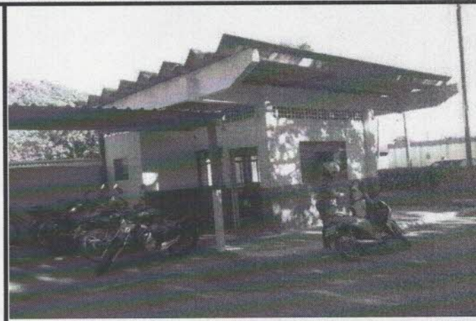
FOTO 12 - Guarita da Residência Rodoviária de Gurupi - Ageto.
