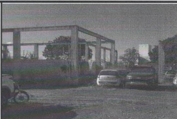
FOTO 38 - Área do Posto de Combustível da Ageto.
