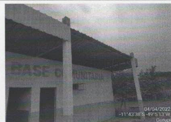
Foto 16 – VISTA PARCIAL EXTERNA
