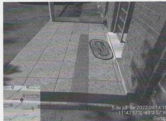
Foto 6 – VISTA PARCIAL PISO CERÂMICO
