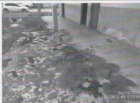
Foto 17 – VISTA PARCIAL EXTERNA
