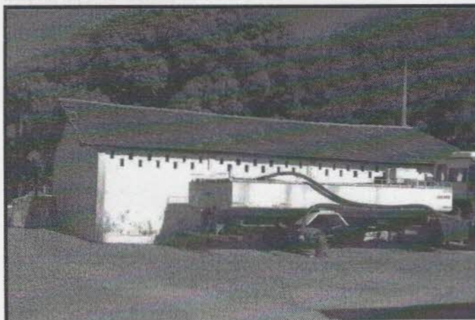
FOTO 53 - Depósito de Lubrificantes da Residência Rodoviária de Gurupi.
