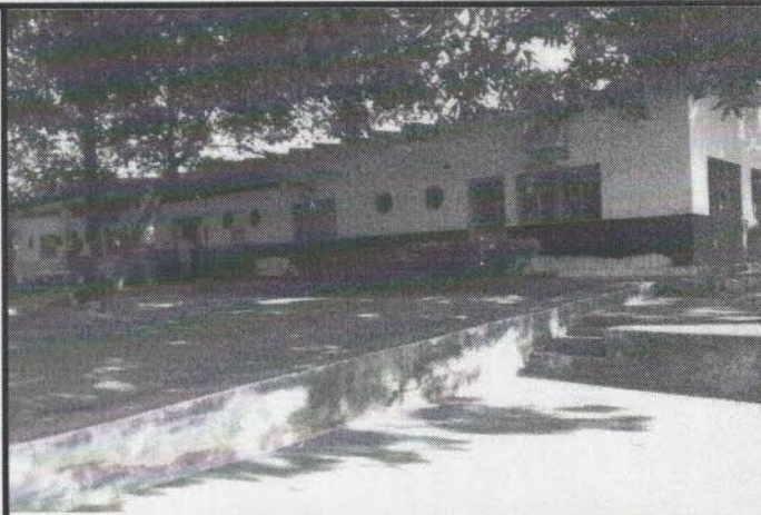
FOTO 4 - Prédio da Administração da Residência Rodoviária de Gurupi - Ageto.
