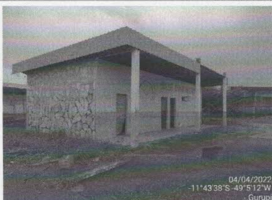
Foto 15 – VISTA PARCIAL EXTERNA
