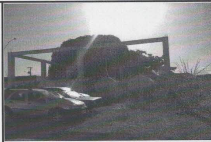
FOTO 42 - Área dos Tanques do Posto de Combustível da Ageto.
