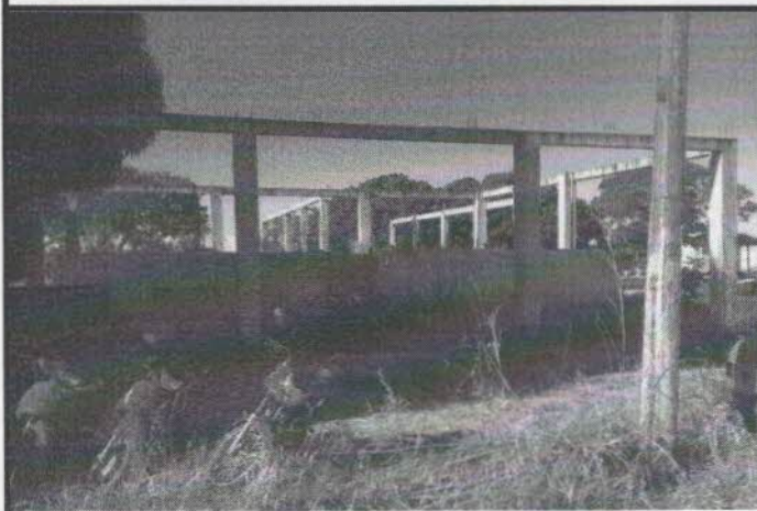
FOTO 39 - Área dos Tanques do Posto de Combustível da Ageto.
