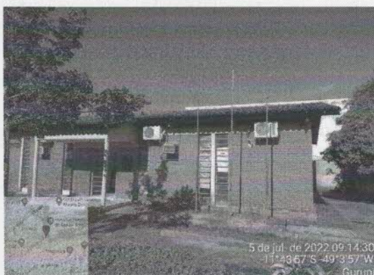
Foto 3 – VISTA PARCIAL EXTERNA
