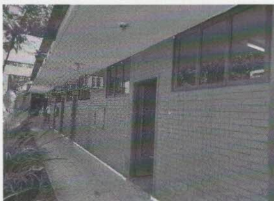
Foto 3 – VISTA PARCIAL EXTERNA
