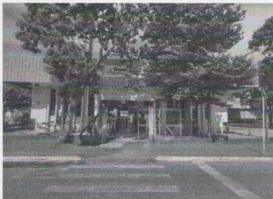
Foto 1 – VISTA PARCIAL EXTERNA PRÉDIO ADMINISTRATIVO
