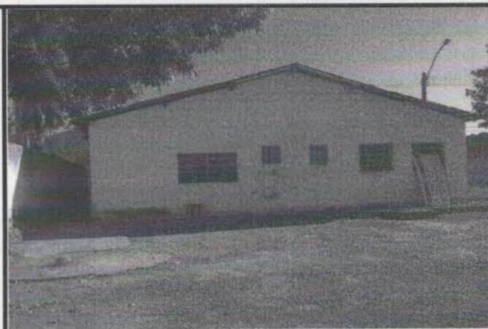
FOTO 60 - Casa de Apoio da Residência Rodoviária de Gurupi.
