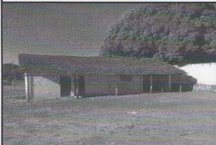
FOTO 57 - Depósito de Materiais e Equipamentos da Equipe de Roçagem.
