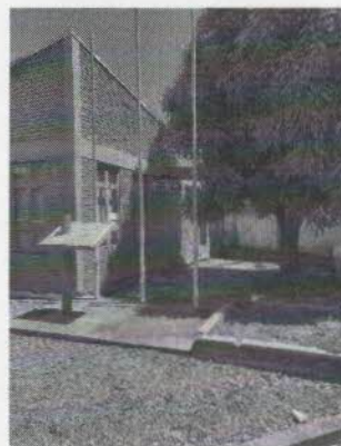
Foto 2 – VISTA PARCIAL EXTERNA
