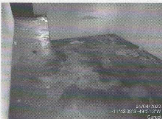
Foto 13 – VISTA PARCIAL INTERNA
