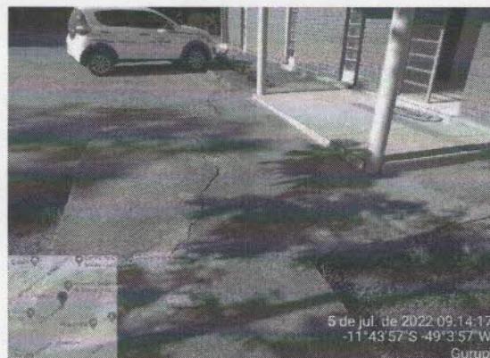
Foto 2 – VISTA DA FACHADA DO PRÉDIO
