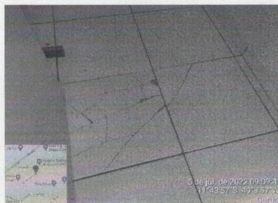
Foto 4 – VISTA PARCIAL PISO CERÂMICO
