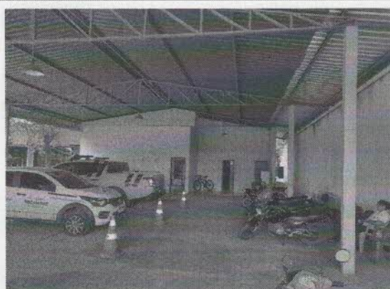
Foto 5 – VISTA PARCIAL PRÉDIO FISCALIZAÇÃO
