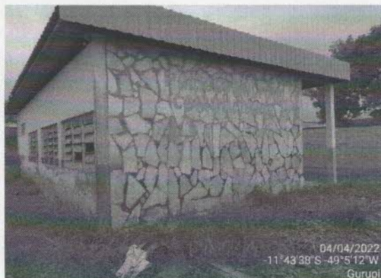
Foto 1 – VISTA PARCIAL EXTERNA
