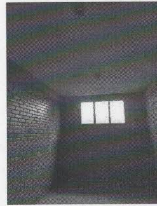
Foto 12 – VISTA PARCIAL INTERNA
