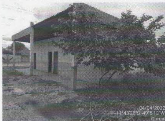
Foto 8 – VISTA PARCIAL EXTERNA
