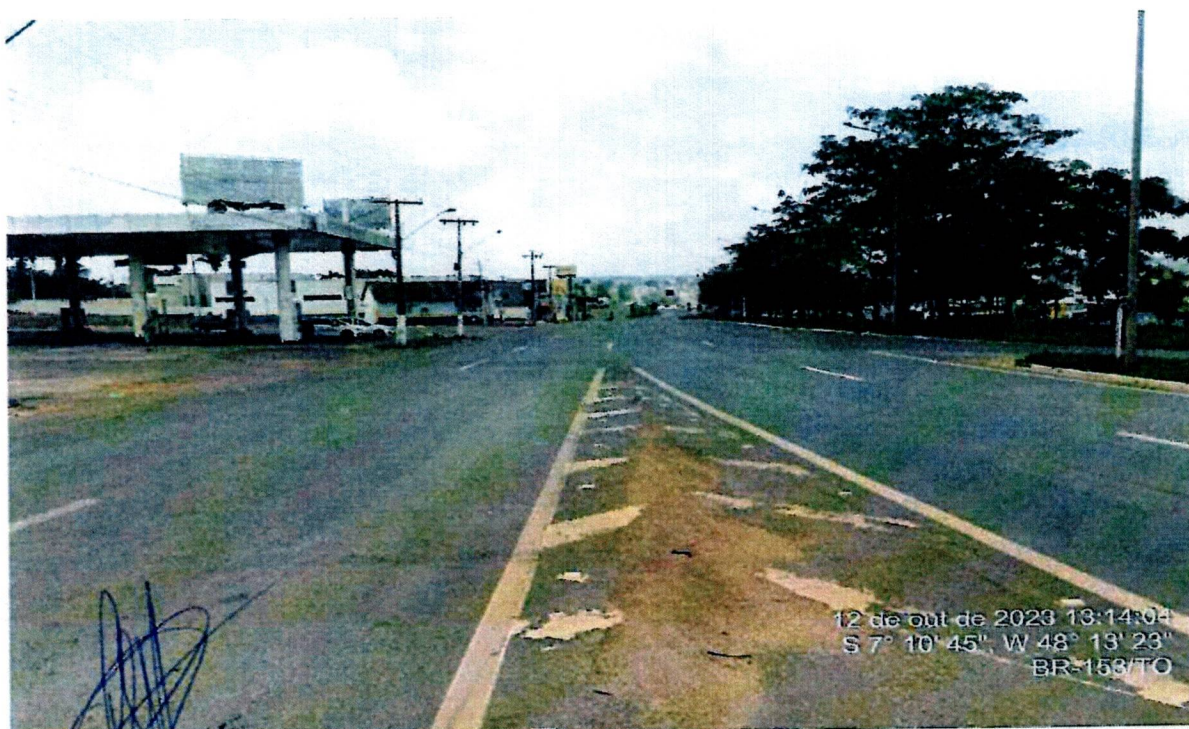
Foto 2 - Pista sentido crescente no Trevo Entroncamento KM=140,560
