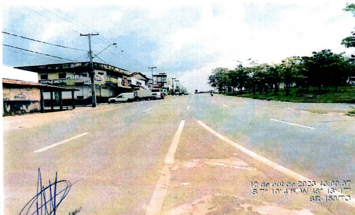
Foto 6 - Pista sentido decrescente no Trevo Entroncamento KM=140,260
