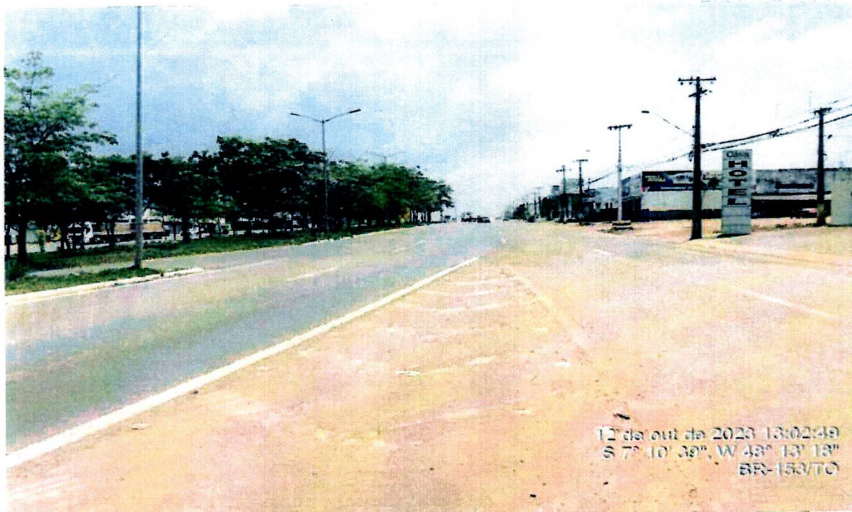
Foto 1 - Pista sentido crescente no Trevo Entroncamento KM=140,260
