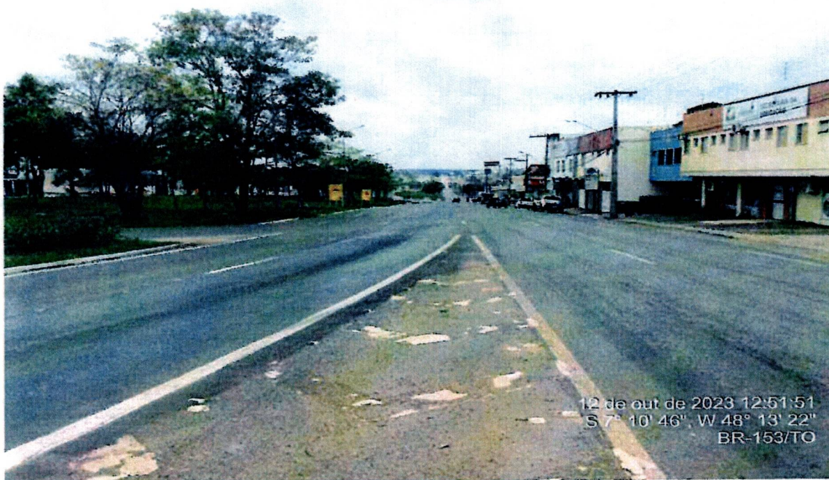
Foto 5 - Pista sentido decrescente no Trevo Entroncamento KM=140,560
