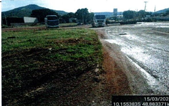
FOTO: 05 - MEIO FIO
