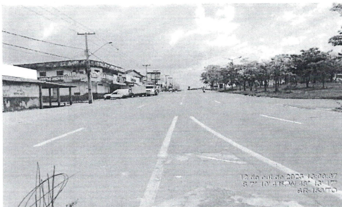
Foto 6 - Pista sentido decrescente no Trevo Entroncamento KM=140,260
