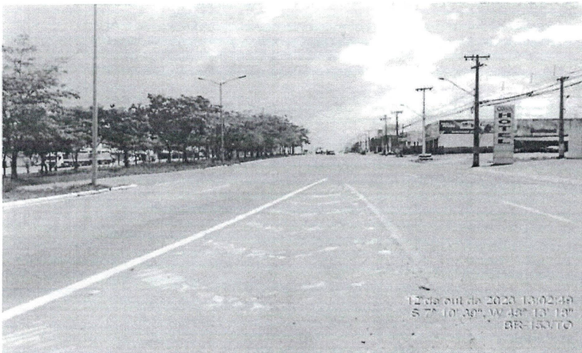
Foto 1 - Pista sentido crescente no Trevo Entroncamento KM=140,260
