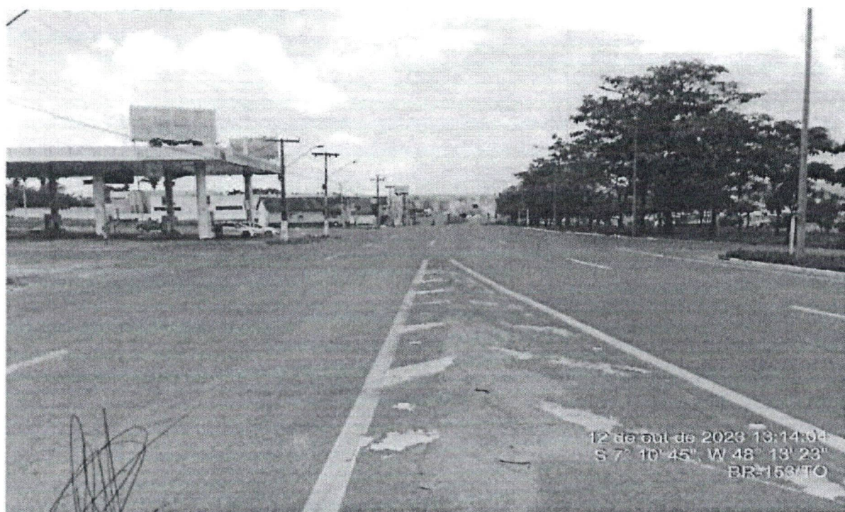
Foto 2 - Pista sentido crescente no Trevo Entroncamento KM=140,560
