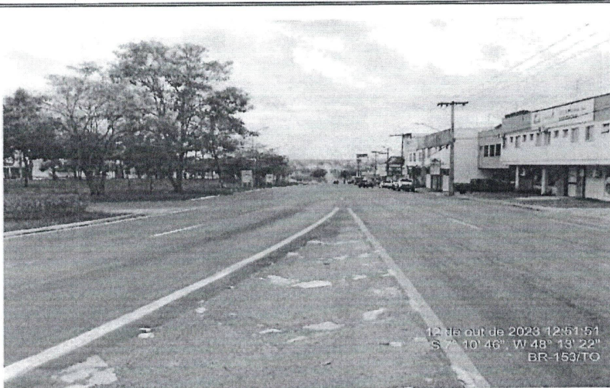
Foto 5 - Pista sentido decrescente no Trevo Entroncamento KM=140,560
