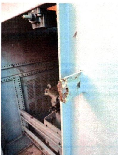
Imagem 10 – Vandalismo Ponte da Amizade e da Integração Nacional
