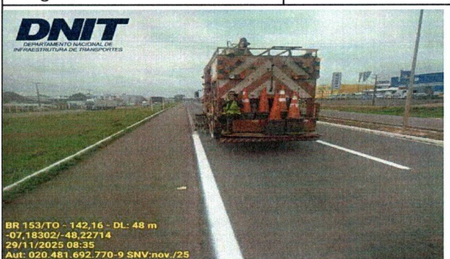
FOTO: 03 - IMPLANTACAO HORIZONTAL - PINTURA DE FAIXA
