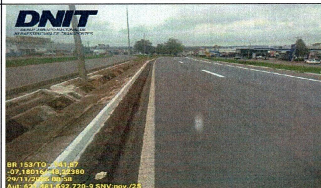
FOTO: 02 - IMPLANTACAO HORIZONTAL - PINTURA DE FAIXA
