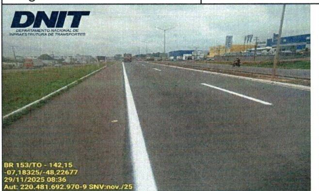
FOTO: 05 - IMPLANTACAO HORIZONTAL - PINTURA DE FAIXA
